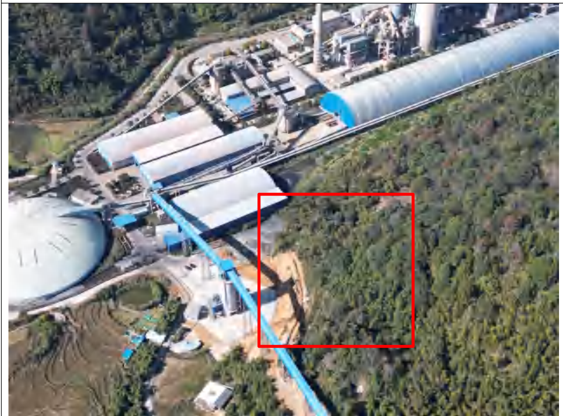
2#临时堆土场（红线范围内）
